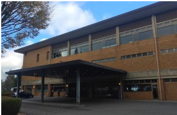
ゴルフ場のエントランスらしい外観です
